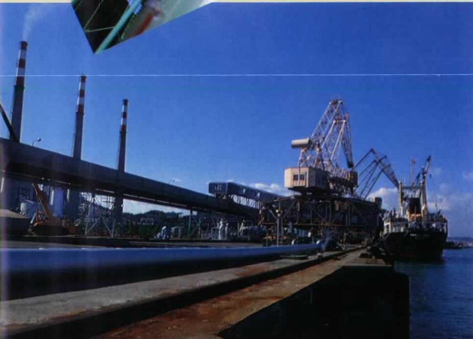
仙台火力発電所。中国炭を積んだ船が入港中。
