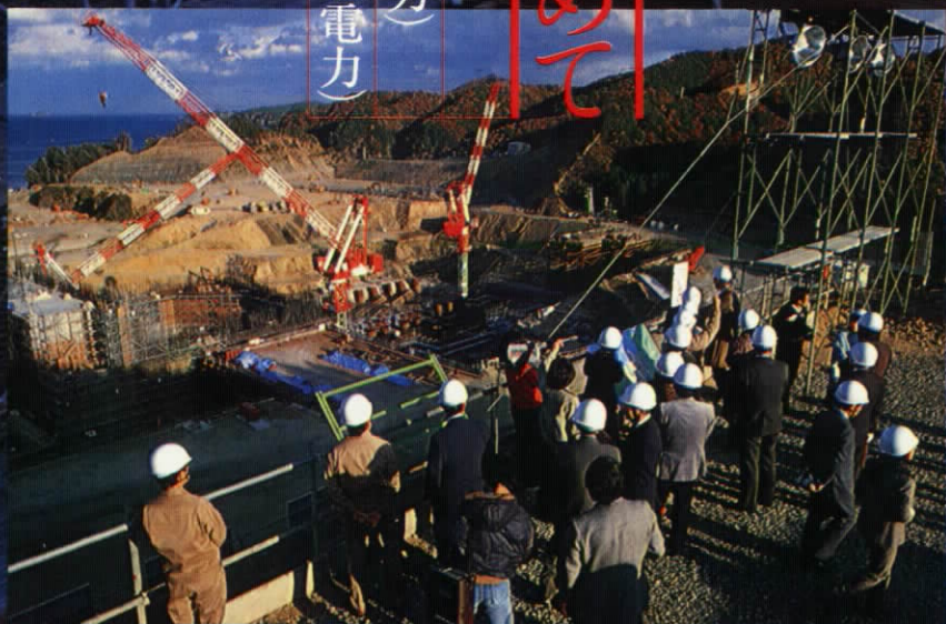
排気管建設予定地からは建設現場が一望のもとに
